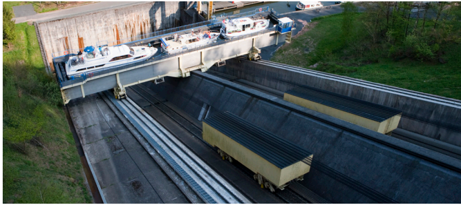
Das Schiffshebewerk in Arzwiller.
